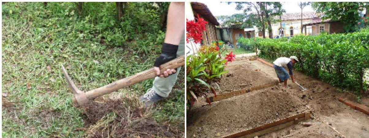
Beginn und Abschluss der Arbeiten am Garten
