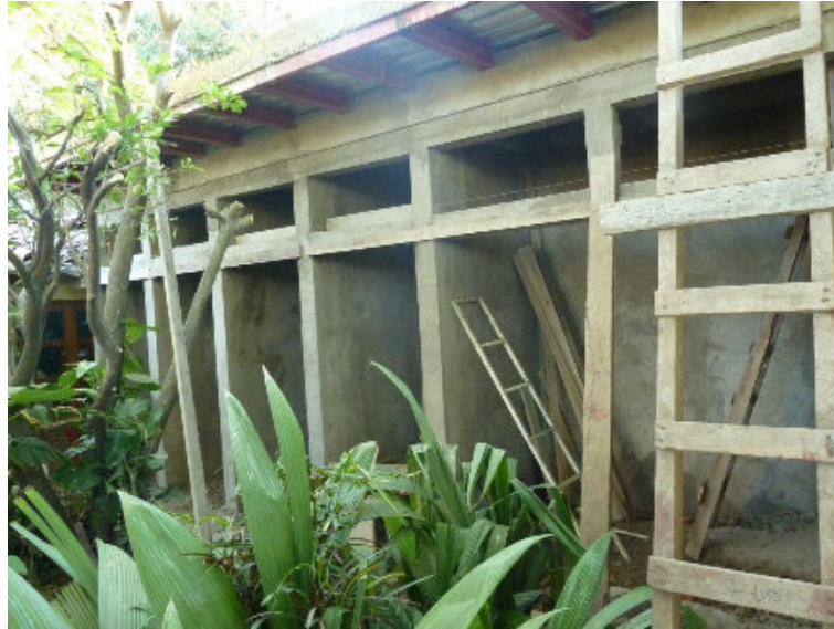
Fortgeschrittene Konstruktion der neuen Bäder
