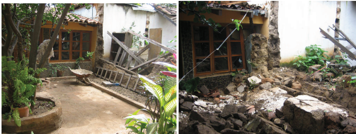
Mauervergleich jetzt und vorher
