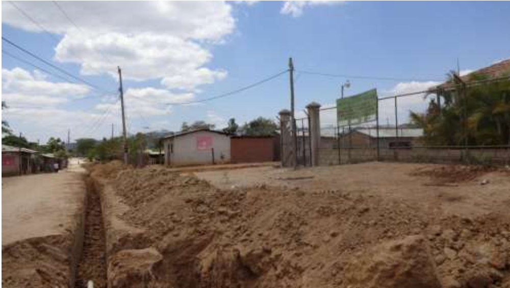
Verlegung der Wasserleitung vom Preescolar zur Casita in Nuevo Amanecer
